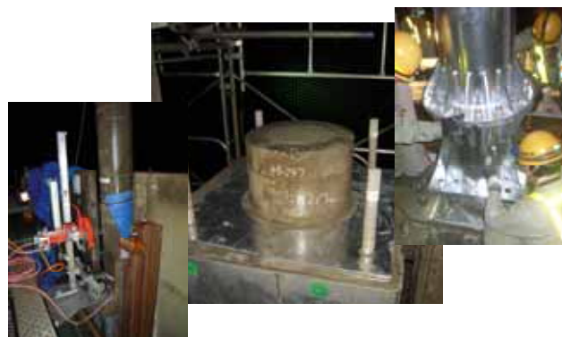
スチールワイヤーを使用した電柱切断工法での施工の様子
