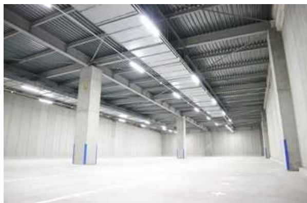
冷蔵（冷凍）倉庫
