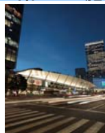
【新設】 東京GRANROOF (東京都千代田区)
