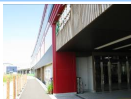
【改良】 仙石線多賀城駅 (宮城県多賀城市)
