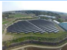
【新設】 茨城県筑西市太陽光発電所 (茨城県筑西市)
