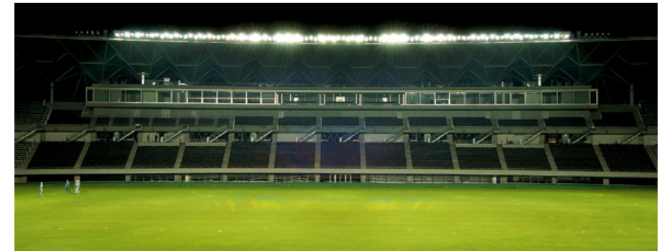
千葉市総合スポーツ公園市民球技場（千葉県千葉市）
