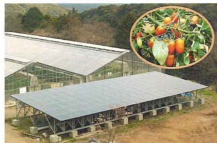
伊豆奥下田 観音温泉トマトハウス(静岡県下田市) 多結晶 20kW 高圧系統連系
