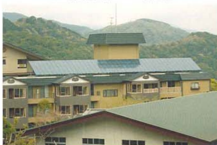
伊豆奥下田 観音温泉本館(静岡県下田市) 多結晶 20kW 高圧系統連系
