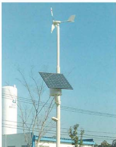
ハイブリッド型 定格出力 350W (熊本県大津町)
