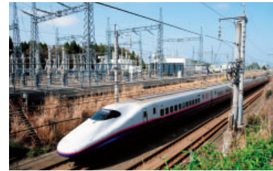
新仙台変電所 (宮城県名取市)
