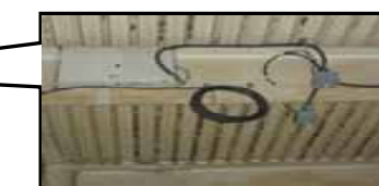
WiMAX小型無線基地局装置 とアンテナ(田町駅)
