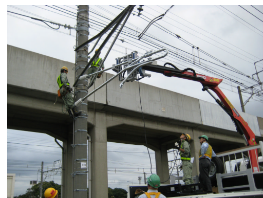
可動ブラケットを電車線柱に取付ける作業状況
