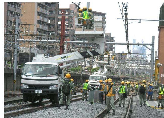
京浜東北線(北行)線路切換工事における電車線調整作業 2008.5
