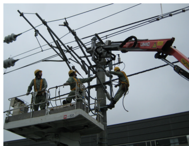
可動ブラケットを電車線柱に取付ける作業状況
