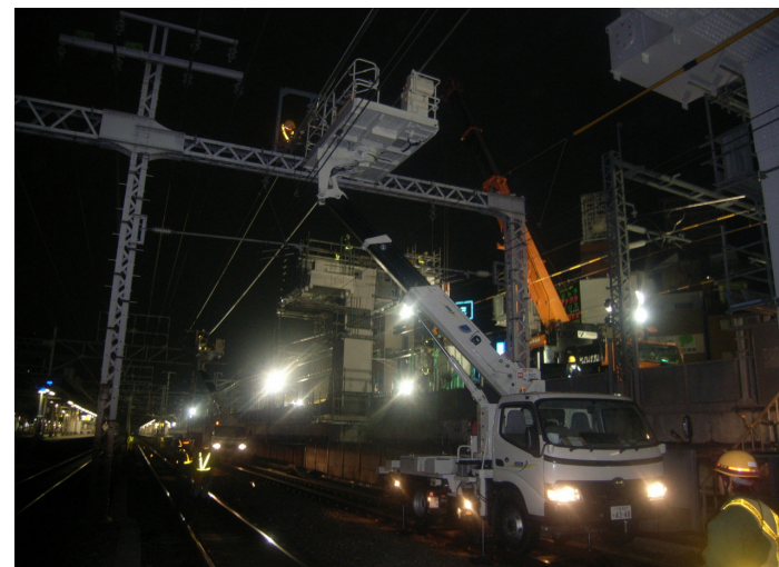
土木桁架設に伴う 電車線支障移転作業 2010.2
