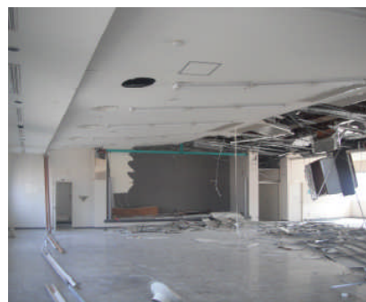
未来工業(茨城工場) 天井崩落
