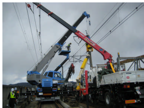
東北新幹線 仙台付近 電柱建替工事
