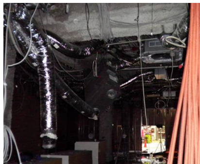
水戸エクセル ダクトの抜け落ち
