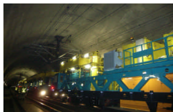
電車線路架線設備の張替工事の様子 東北新幹線 仙台～古川間
