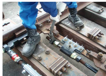
電気転てつ機の調整金具 (東日本電気エンジニアリング)
