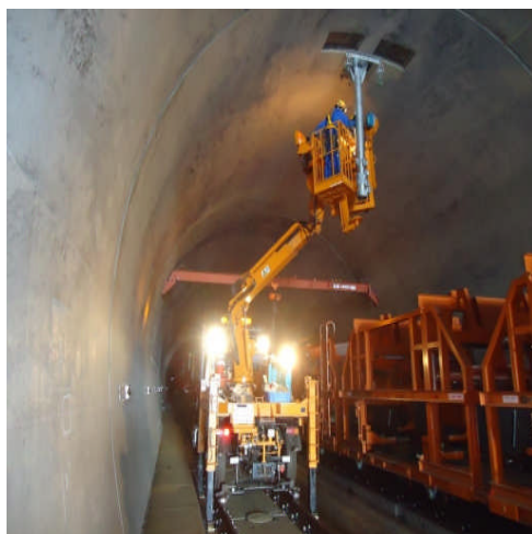
軌陸車使用による高田トンネル内下束施工中 上越(仮称)～糸魚川間
