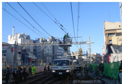
土木橋脚新設に伴う電車線支障移転作業 東京～上野間
