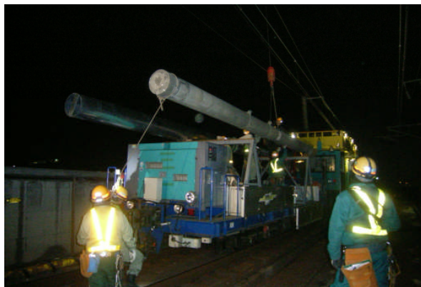
電化柱建替工事の様子 東北新幹線 仙台駅構内
