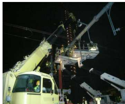
東北貨物線新設工事に伴う 電車線支持物新設作業 浦和駅構内
