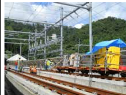
糸魚川き電区分所付近での電車線耐圧試験
