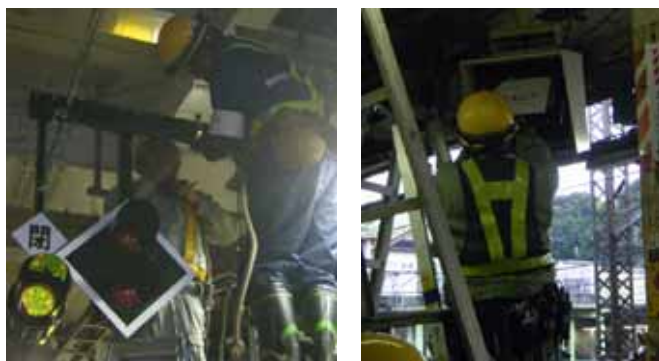
ホーム上の信号設備および通信設備の移転作業 (2013年10月20日常磐線日暮里駅ホーム拡幅工事に伴う切換工事) 受注 2億円
