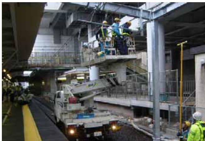
電車線設備移転作業
