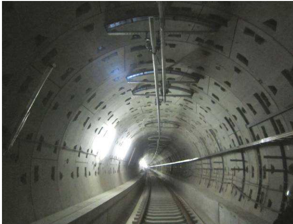
剛体架線 (NDK導電鋼レール)設置 受注19億円
