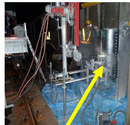
鋼板を電化柱に巻きつけて補強する工法
