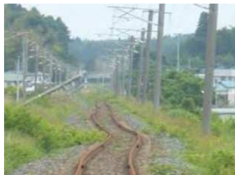
軌道変状、電車線柱倒壊
