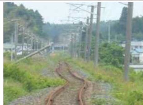
軌道変状、電車線柱倒壊 東日本旅客鉄道プレス資料より
