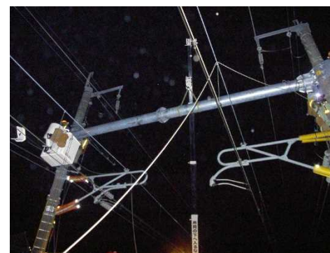
電化柱耐震補強工事
