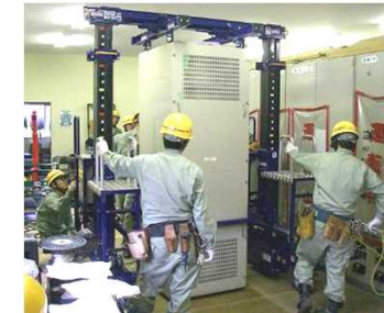
開発品を使用した施工方法
