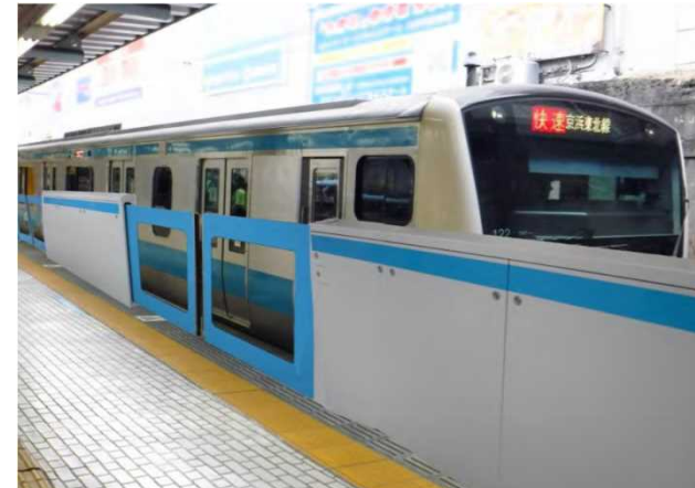
【京浜東北線ホームドア設置工事】
