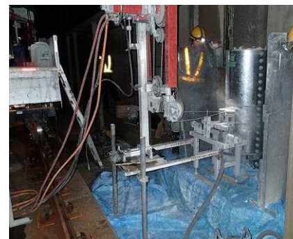
電化柱耐震補強工事(高じん性化)
