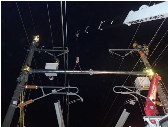
【東北新幹線電化柱耐震補強工事】
