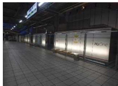
武蔵溝ノ口駅水素発電機設置工事
