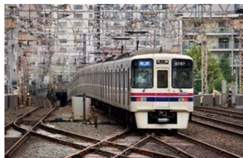
京王電鉄(株) 新宿～笹塚間ロングレール交換付帯信号工事
