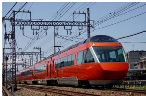
小田急電鉄(株) 支持物建替工事(渋沢～新松田間)
