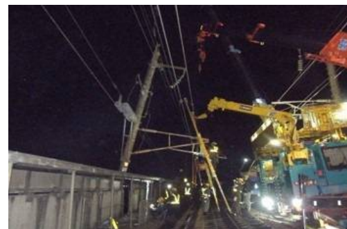
電柱折損箇所
