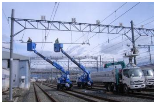
電車線路復旧工事の様子
