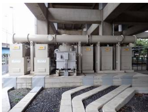
変電所機器取替
