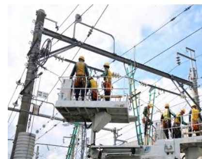
電車線実習 (軌陸車を150台保有)
