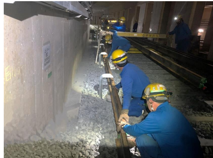
大阪市高速電気軌道(株)夢洲～コスモスクエア間サードレール工事 NEW
