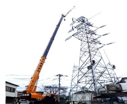
架空送電線路鉄塔立替
