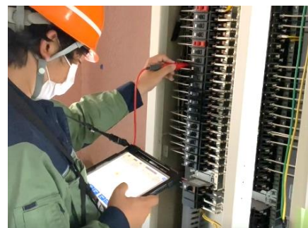
絶縁抵抗測定表自動作成システムの開発
