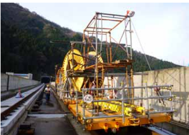
上越～糸魚川間 高圧ケーブル新設
