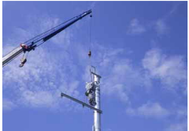
長野～飯山間 腕金新設
