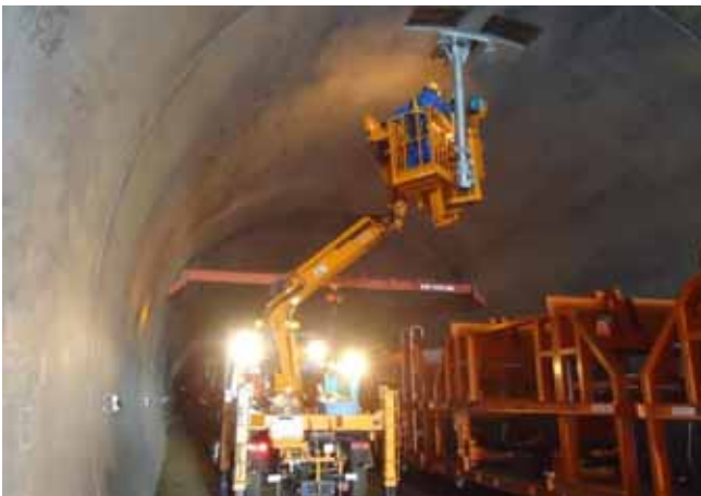
高田トンネル内 電車線下束新設
