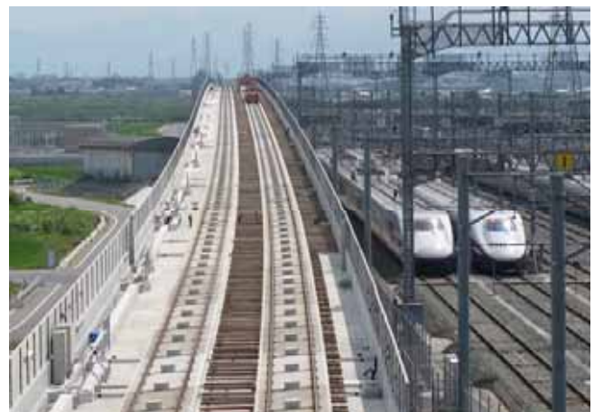
長野県長野市 赤沼高架橋 (鉄道建設・運輸施設整備支援機構HPより)
