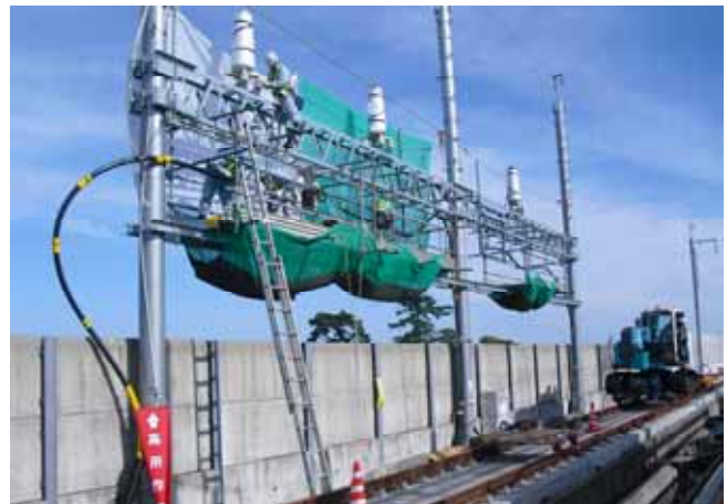
新糸魚川き電区分所付近 き電ケーブル新設
