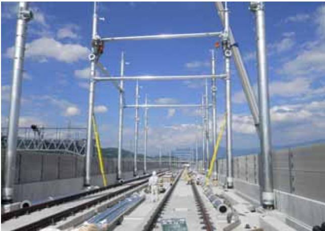
新長野変電所付近 ストラクチャー新設
