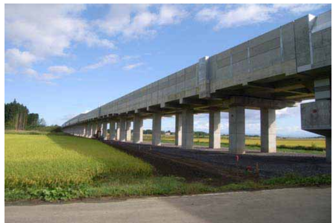
青森県青森市 後潟高架橋 (鉄道建設・運輸施設整備支援機構HPより)
