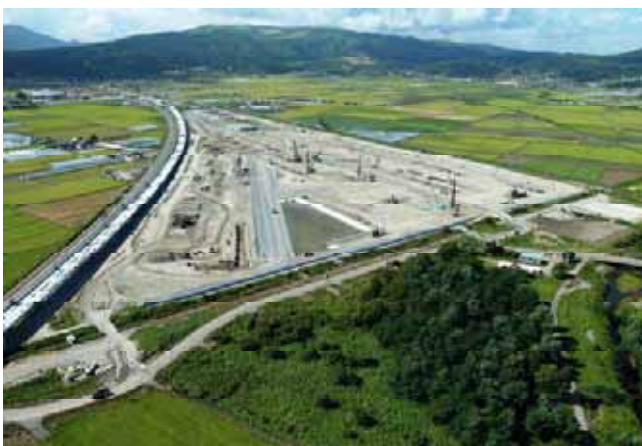
北海道北斗市/七飯町 函館総合車両基地 (鉄道建設・運輸施設整備支援機構HPより)
