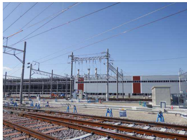
仕業検査庫付近
