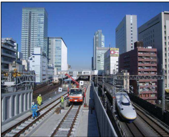
【電車線設備】 支持物新設
