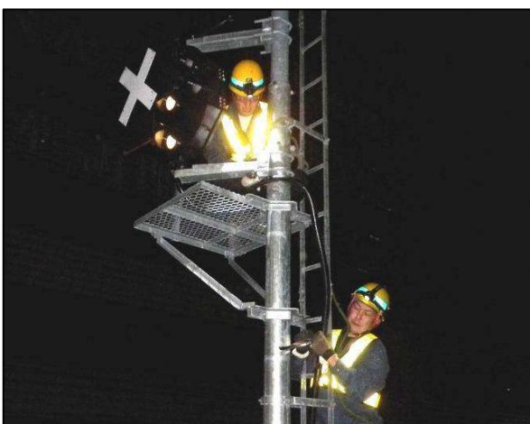
【信号設備】 信号機新設
