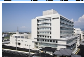
【新設】 三豊総合病院 (香川県観音寺市)
