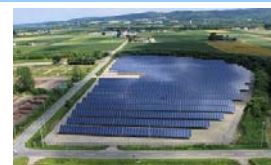
【新設】 幕別太陽光発電所 (北海道中川郡)
