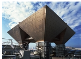
【改修】 東京国際展示場 (東京都江東区)
