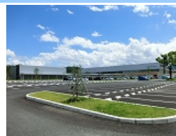
【新設】 総合せき掘センター (福岡県飯塚市)
