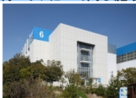
【新設】 大阪体育大学多目的体育館 (大阪府泉南郡)
