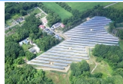
【新設】 恵庭太陽光発電所 (北海道恵庭市)
