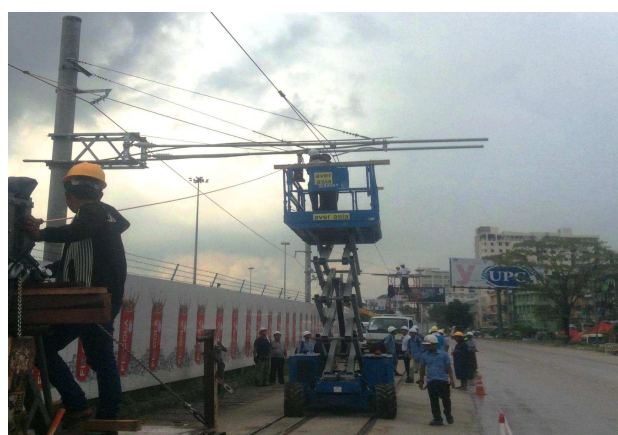
電車線路設備新設工事
