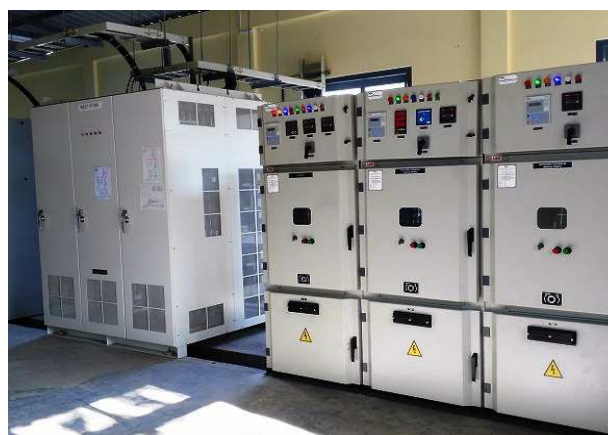
変電所設備新設工事
