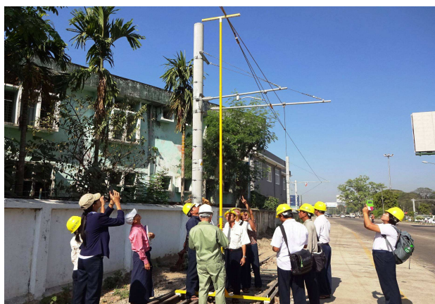
電車線路設備
