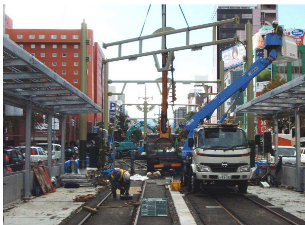
すすきの停留場（施工中）
