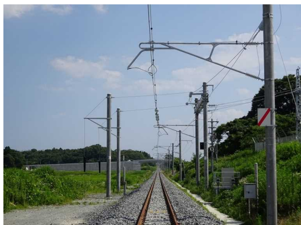
駒ヶ嶺・新地間
