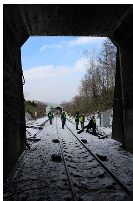
新狩勝信号場・広内信号場間(広内第二トンネル)
