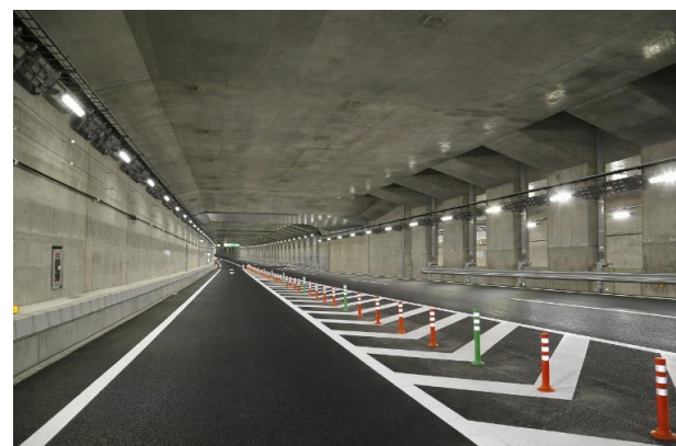
市川南IC（地下区間）
