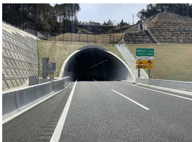
四日市トンネル
