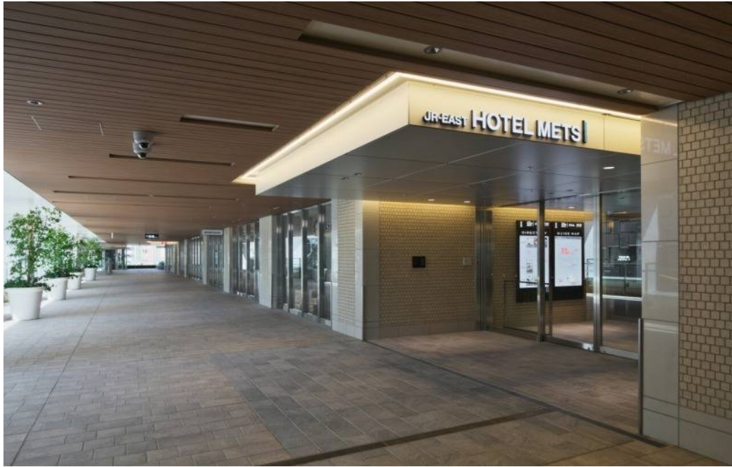
J R 横浜鶴屋町ビル 施設内通路
