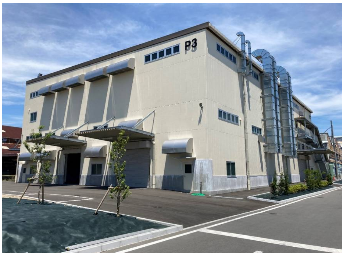
総合車両製作所新部品塗装工場棟 外観
