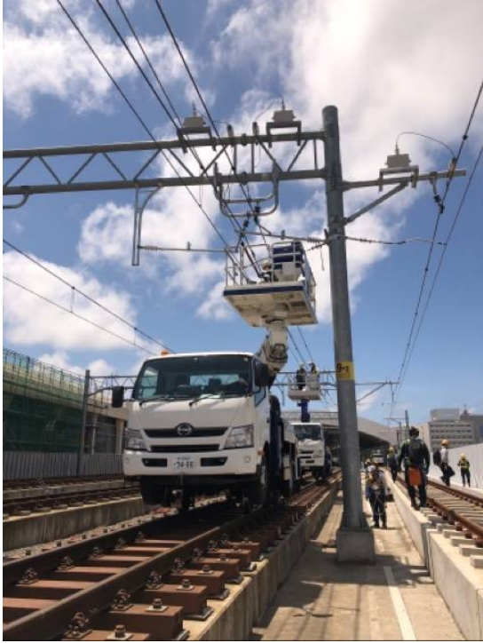
駅部電車線作業
