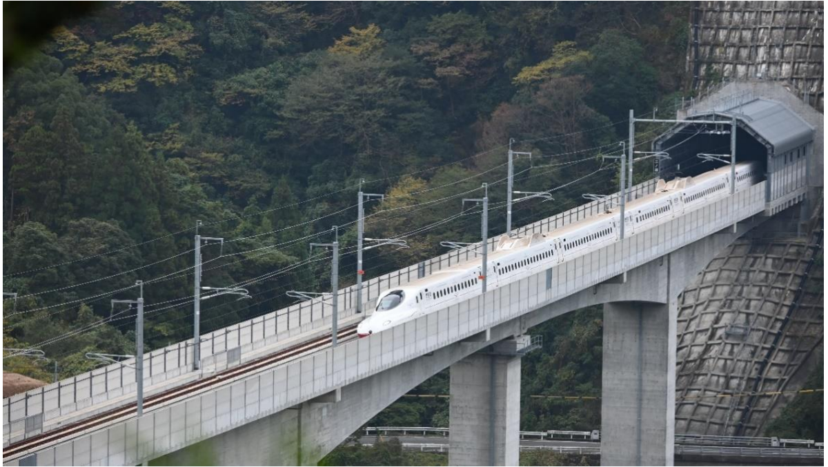
嬉野温泉駅～新大村駅間（俵坂トンネル）彼杵橋梁
