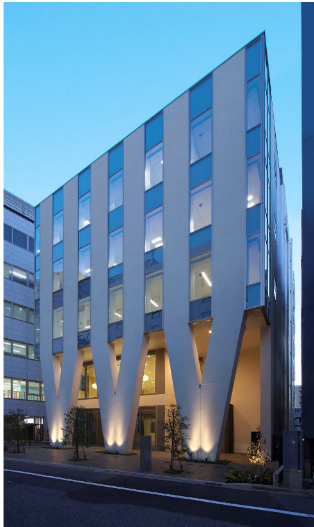
ペリエ+plusビル 外観（ライトアップ）
