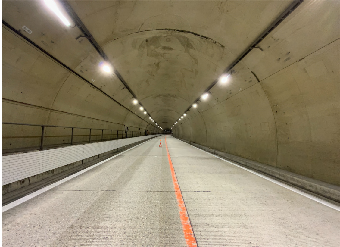
中国自動車道 加計東トンネル（下り）内部
