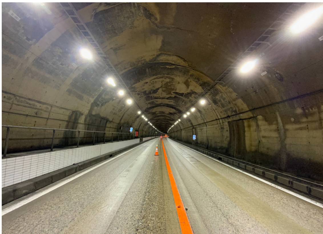
中国自動車道 加計東トンネル（上り）内部
