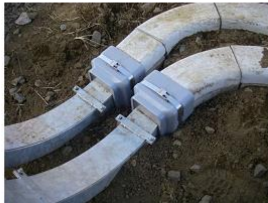
(施工例) トラフ120と保護樋110との接続部
