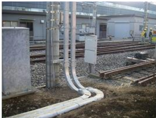
(施工例) トラフ120と保護樋110との接続部
