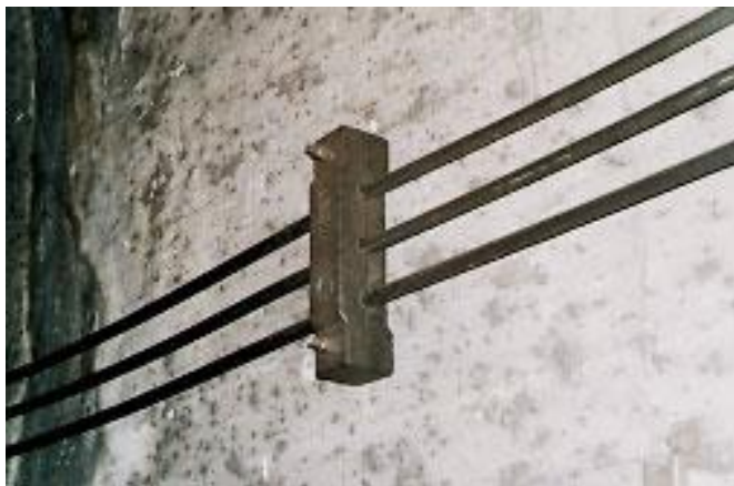
トンネル内側壁取付施工例
