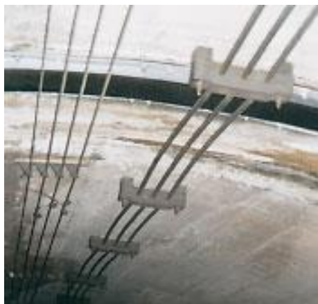
トンネル内上部取付施工例
