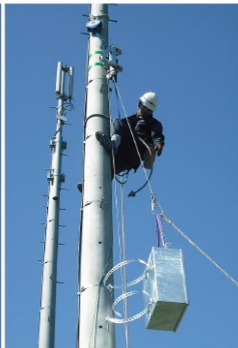
巻き上げ作業
