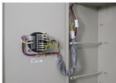
プラグイン式ブレーカの採用 ブレーカレバーに誤操作防止カバー
