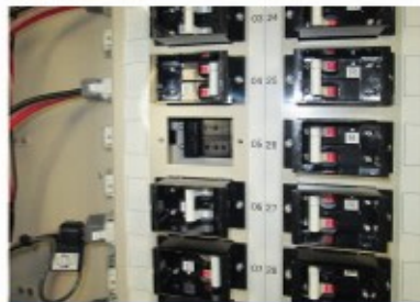
プラグイン式ブレーカの採用 ブレーカレバーに誤操作防止カバー
