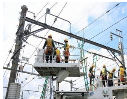
電車線実習 (軌陸車を150台保有)
