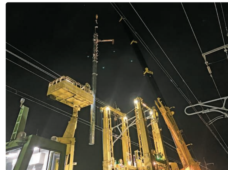
鋼管柱建替工事
