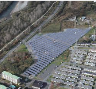
日本電設白老町川沿ソーラーファーム 設置面積：約25,700㎡ 発電規模：約1,250kW
